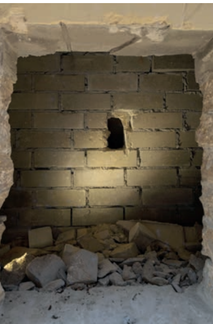
◀ AFBEELDING 19: Kelder 3: opening en achterliggende muur.
