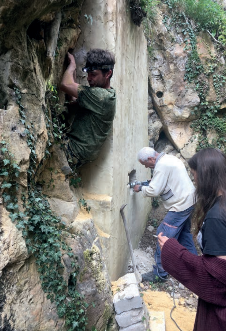
◀ AFBELDING 16: Afsluiting en kruipopening Kelder 2.
